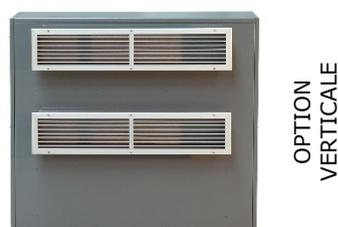
L'appareil même est installé dans un local technique adjacent. L'aspiration et le soufflage sont conduits à travers le mur et seulement les grilles en aluminium ne sont visibles dans le local à déshumidifier
